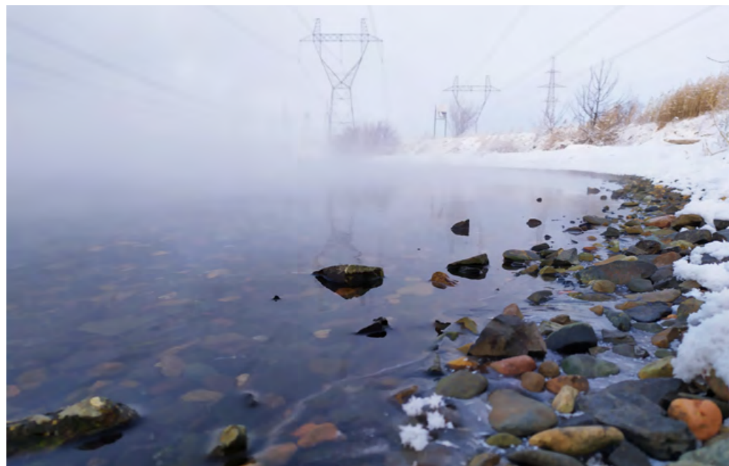
Алексей Рубцов Березовская ГРЭС
