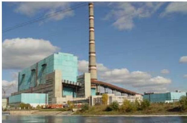
Кроме того, ОГК-4 ведет работы по модернизации оборудования энергоблоков № 1 и № 2 на Березовской ГРЭС. Это позволит увеличить установленную мощность каждого из них на 50 МВт с 750 МВт до 800 МВт, предусмотренных изначальным проектом строительства станции. Завершить работы по модернизации энергоблока № 2 планируется в 2010 году, энергоблока № 1 — в 2011 году. Таким образом, ожидается, что к 2012 году совокупная установленная мощность Березовской ГРЭС достигнет 1600 МВт.
